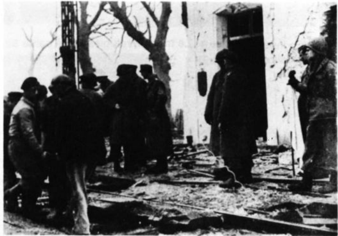
Pose de rails pour rapatrier les 13000 civils.
